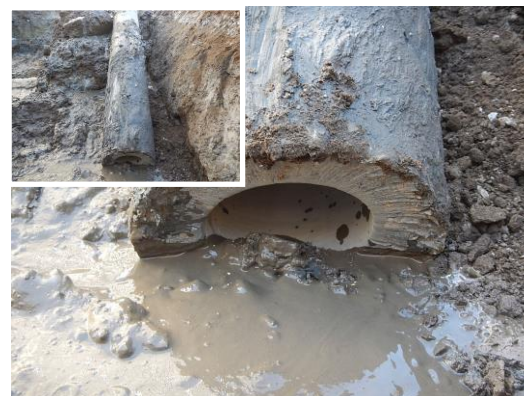
写真-4 コンクリート切断面
