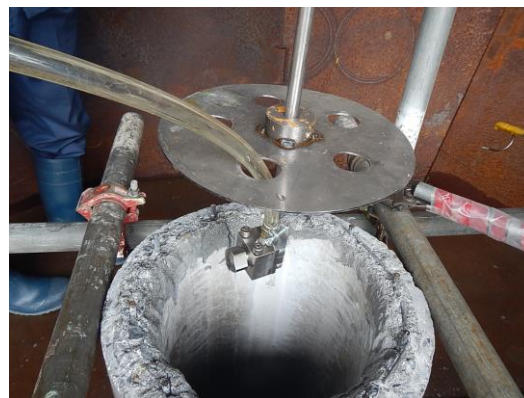
写真-3 超小型 WJC ノズルとノズルガイド
