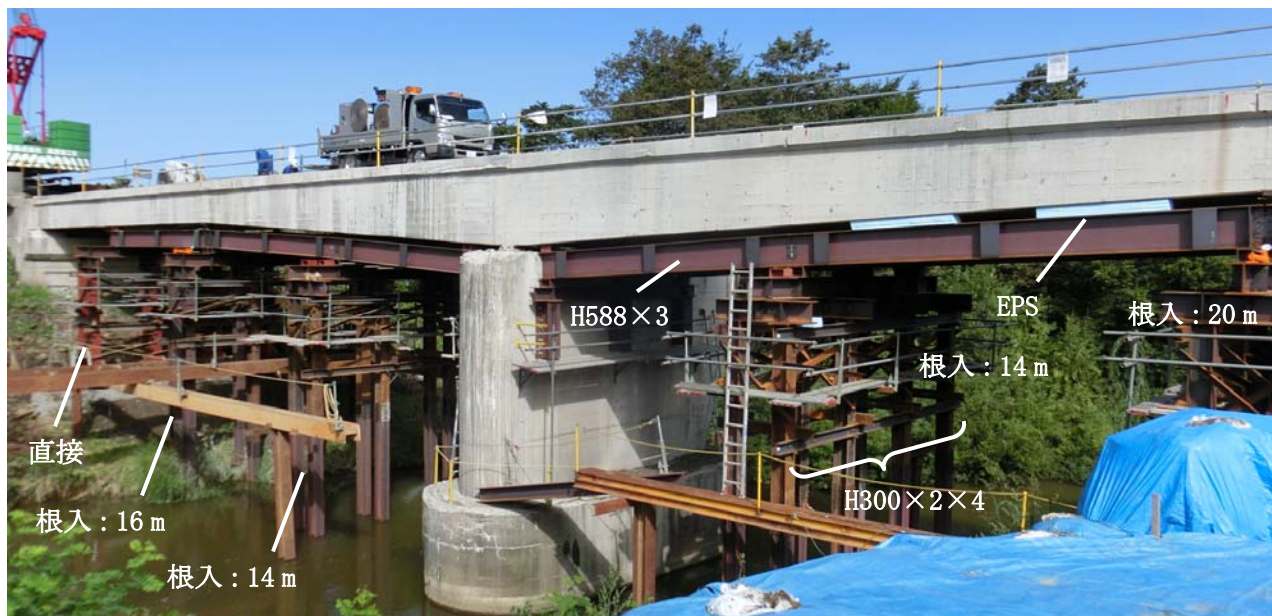
図-1 施工時全体状況
