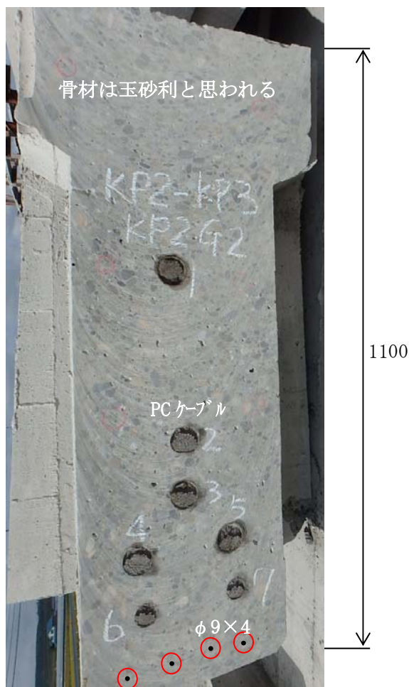
図-3 桁切断面
