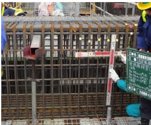
図1 配筋確認検査の例
