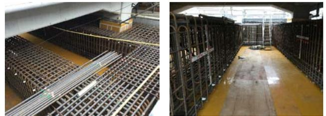
図-5 鉄道高架橋現場において検証した配筋
