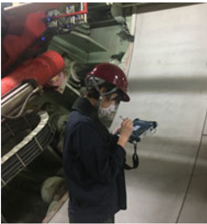
写真-1 坑内作業状況
