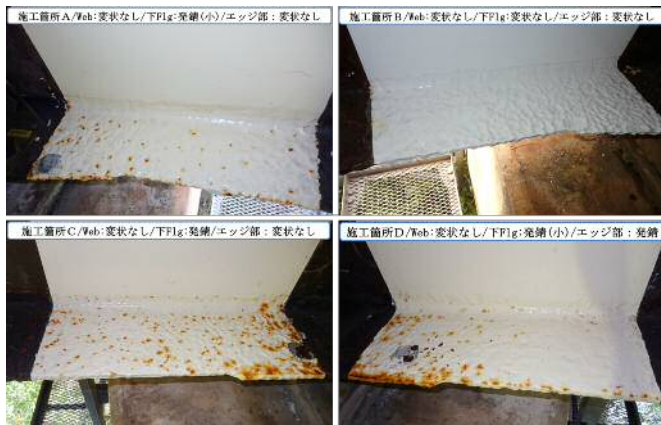
写真-3 実橋梁暴露試験状況
