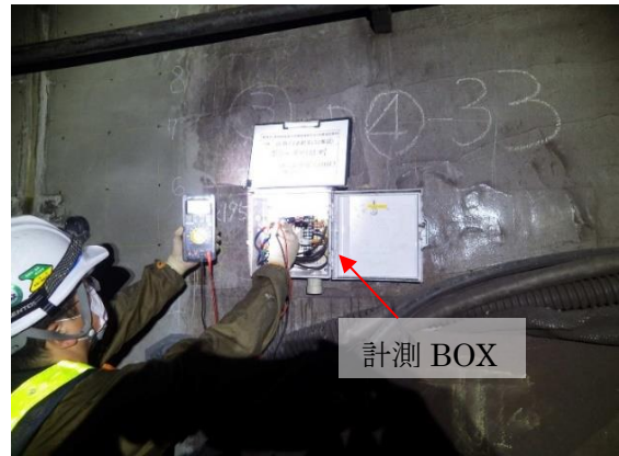
写真-2 測定状況
