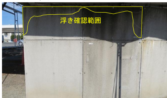
図-4 No. 1 16年経過試験体外観写真
