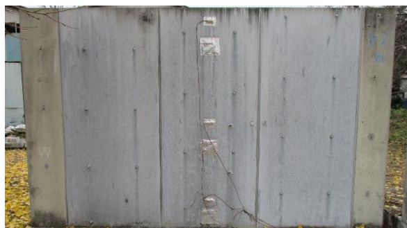
図-5 No. 2 5年経過試験体外観写真
