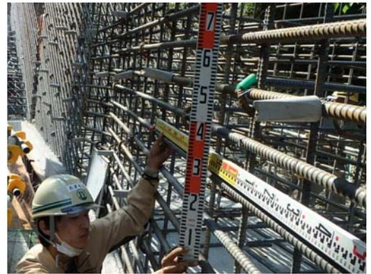
写真-1 ひび割れ補強鉄筋組立状況
