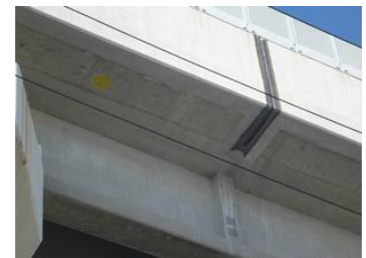
写真-4 含浸剤施工箇所近景
