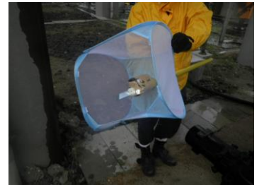
写真-2 叩き落とし棒+飛散対策
