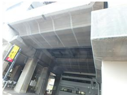
写真-1 ネット工法施工状況
