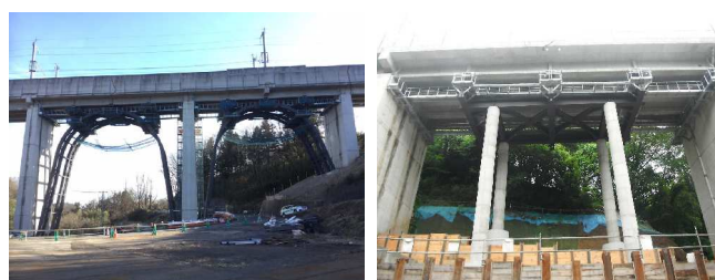
(a) 鋼製アーチ補強
