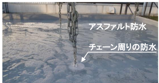
写真-3 模擬足場での湛水試験
