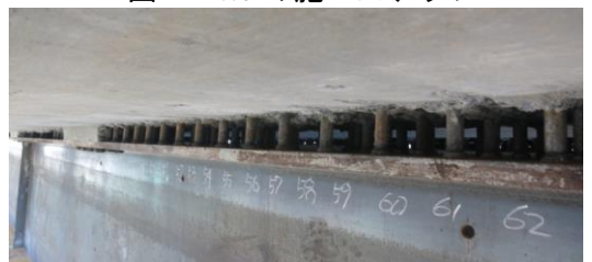
写真-2 大型模型試験体での切削状況
