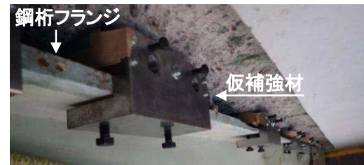
写真-6 仮補強材の設置(阿倍野)
