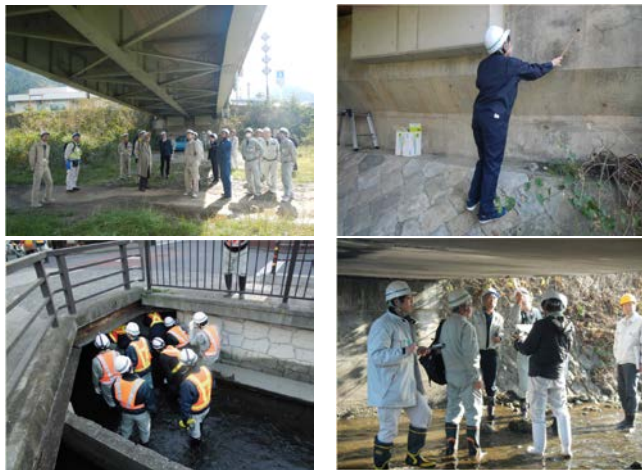
写真-2 対象橋梁の点検・診断実施状況
