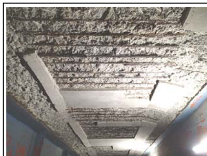
写真 1 脆弱部除去後の床版下面
