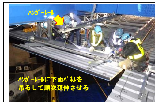
写真4 下面パネル延伸状況
