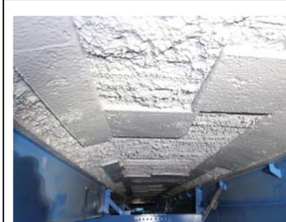
写真 2 塗布系材料による 暫定剥落防止対策後
