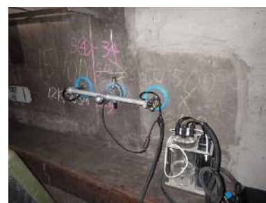
図-2 SWAT 試験装置による表面吸水試験状況
