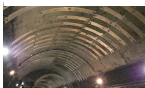
写真-1 帯鋼板の設置状況
