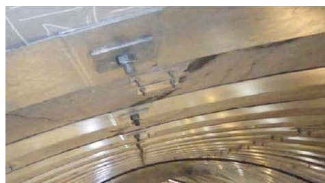
写真-2 ボルト頭部の詳細
