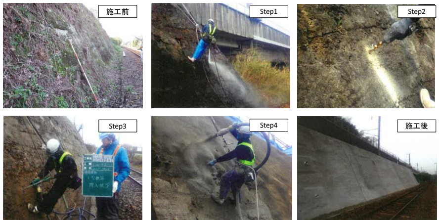
図5 増厚吹付工法の施工手順
