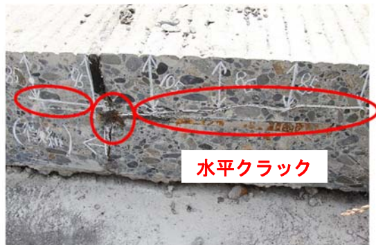
写真-2 コンクリート舗装版内部の状況 その1
