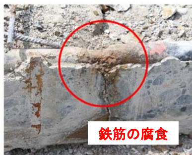
写真-3 コンクリート舗装版内部の状況 その2
