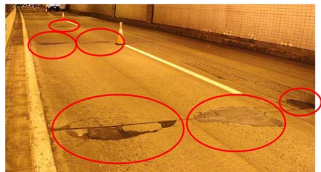
写真-1 ポットホール応急補修跡
