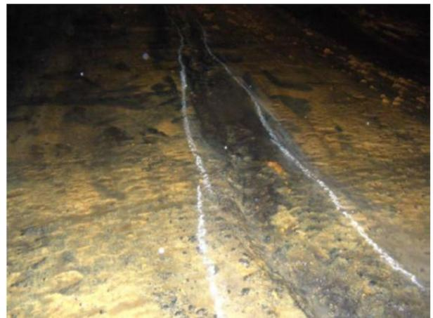
図-2 トンネル継目部の洗掘
