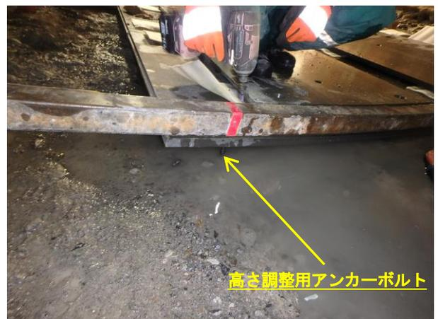
図-7 パネル高さ調整 (試験施工)
