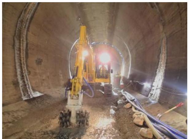
図-3 ツインヘッダーによる切削状況
