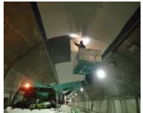
写真 3 炭素繊維シート施工状況
