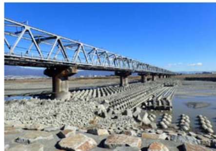
写真-1 新幹線富士川橋りょう
