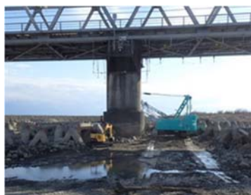
写真-2 根固め工工事
