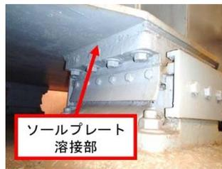
写真-2 ソールプレート溶接
