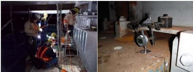
写真-6 反力調整状況
