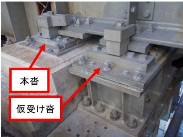
写真-1 施工完了後
