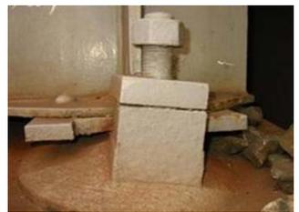
写真-3 沓の沈下
