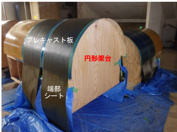
写真4 繊維シートをプレキャスト板化した状況
