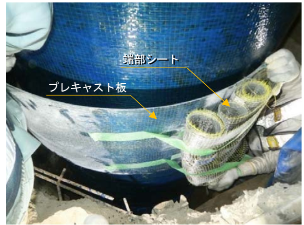
写真5 プレキャスト板設置状況
