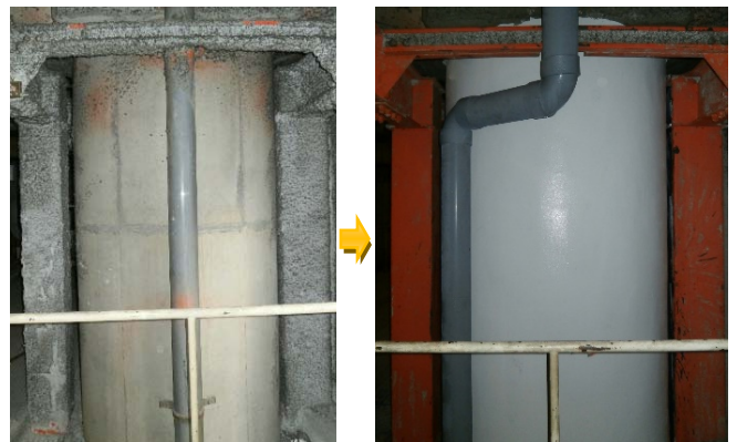
写真6 RC柱の耐震補強・復旧完了
