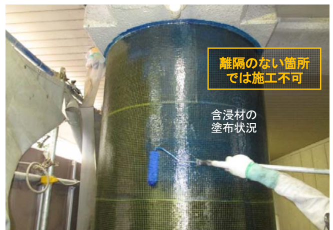
写真 3 炭素繊維巻立て工法
