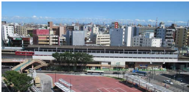
写真 1 京急鶴見駅全景
