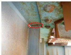
写真2 補剛材き裂状況
