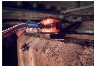
写真-7 ジャッキによる桁扛上
