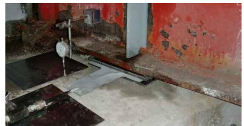
写真-7 施工状況
