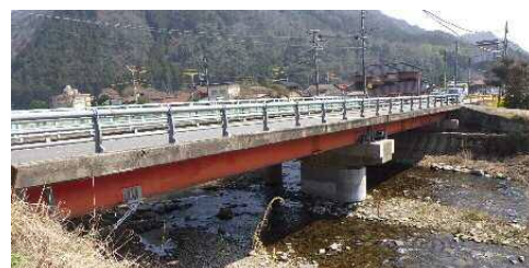
写真-1 橋梁全景
