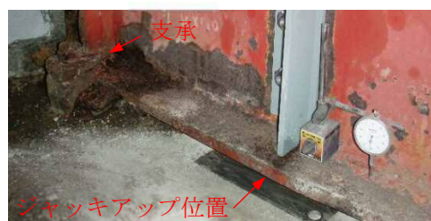
写真-2 既設支承部
