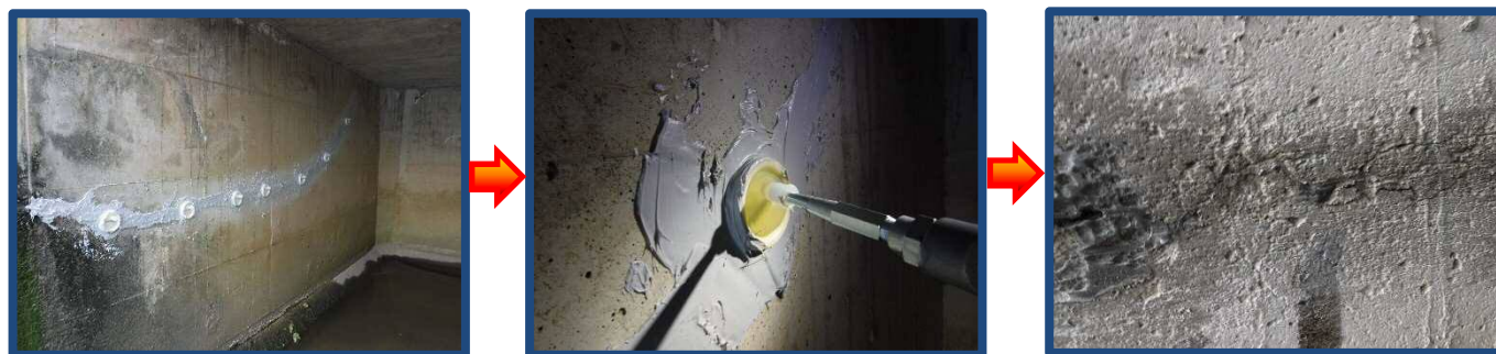
（図-3）直営修繕状況
