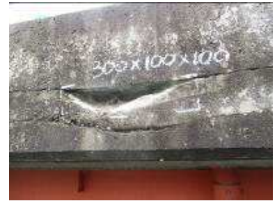
図-5 断面補修箇所
