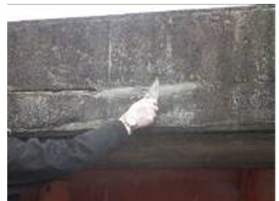
図-8 断面補修状況
