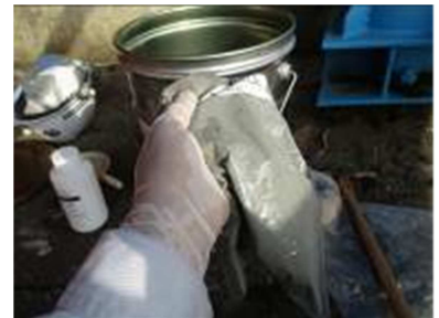
図-7 補修材練り混ぜ状況
