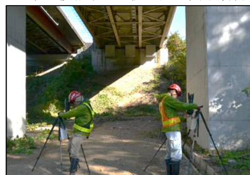
写真-1 高解像度カメラ点検状況
