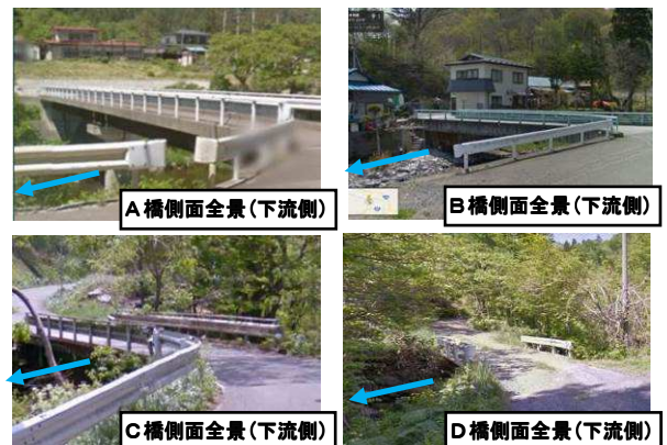
写 1 対象橋梁の被災前状況(←は流水方向)
