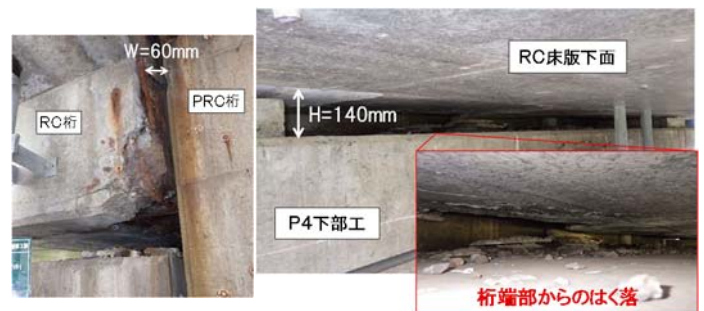
写真-1 桁端部
