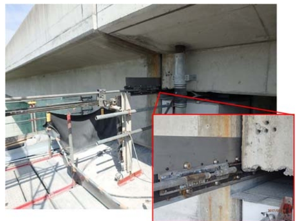
写真-3 側面部のはつり装置
