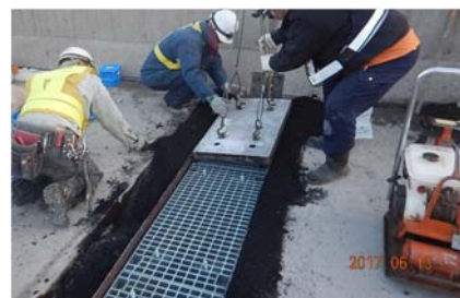
写真-4 仮設伸縮装置設置状況
