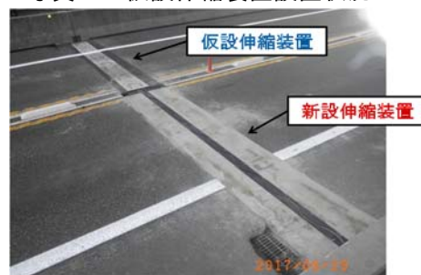
写真-5 新設伸縮装置の設置
