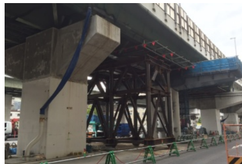
写真-2 仮受け構台設置状況
