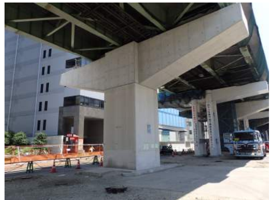
写真-2 再構築後の梁
