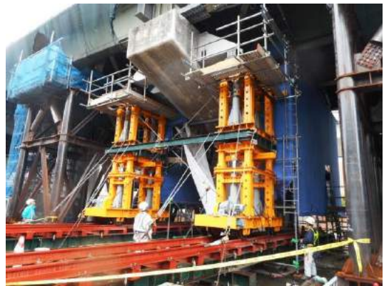
写真-1 梁撤去状況
