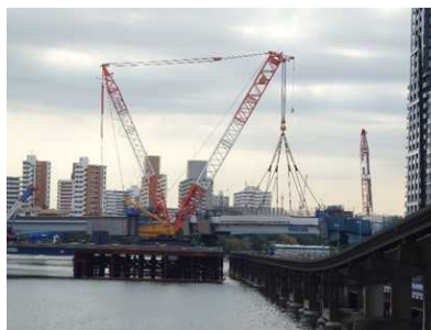
写真-4 1日目作業終了時
