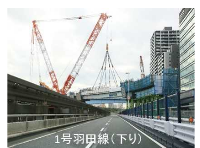
写真-5 1日目作業終了時
