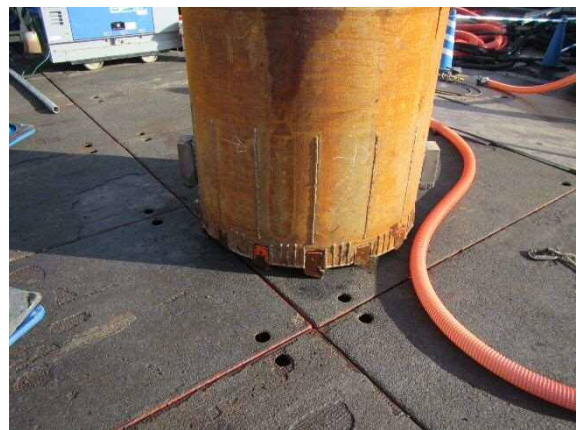
写真-2 ジャイロプレス工法 (左-施工状況，右-杭先端部)
