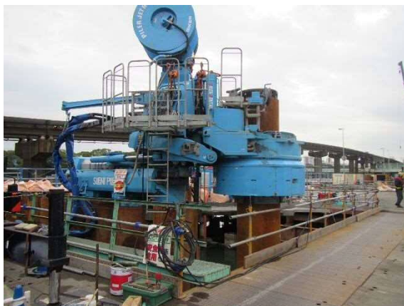
写真-2 ジャイロプレス工法 (左-施工状況，右-杭先端部)
