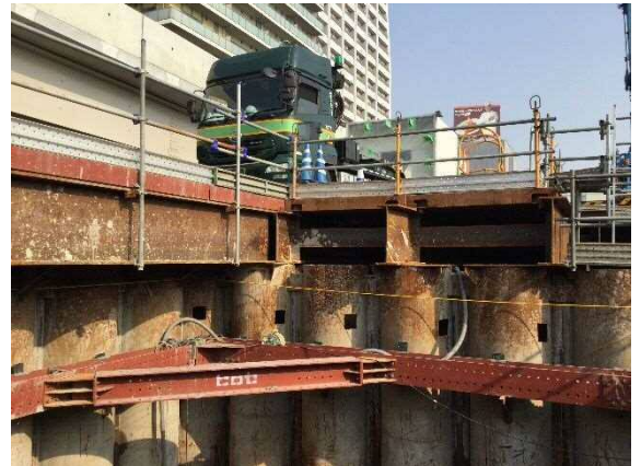
写真-1 栈橋拡幅
