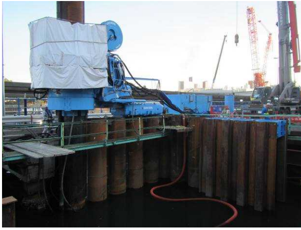
写真-1 鋼管矢板井筒基礎打設状況
