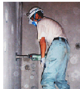
図-1 NAPP アンカー工法の概要図
