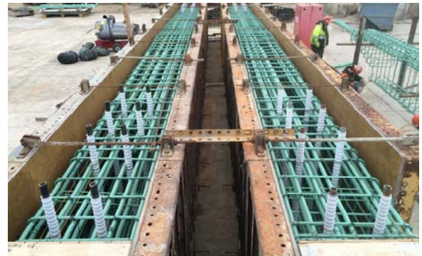
写真-1 PCa 柱頭部のダクト・鉄筋配置状況
