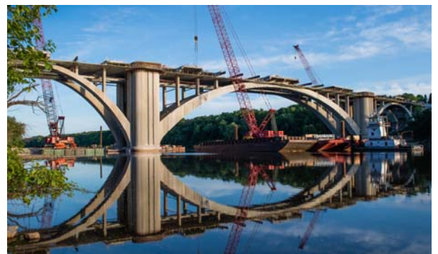
写真-2 PCa 部材架設状況
