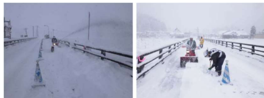
写真6 規制帯内の除雪作業状況
