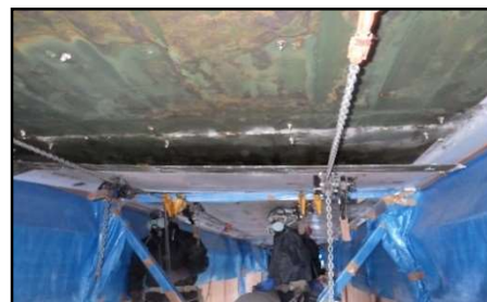
写真3 鋼板撤去の落下防止対策
