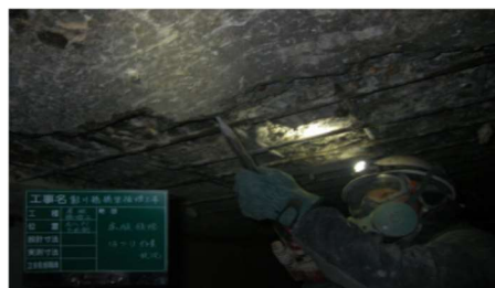
写真4 浮き部の斫り状況
