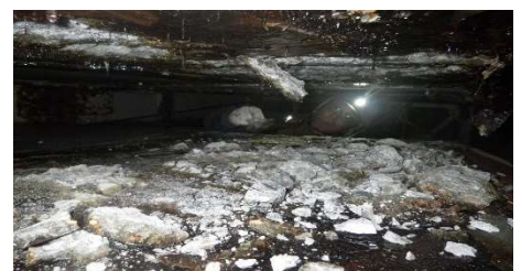
写真 2 鋼板を剥がした状況
