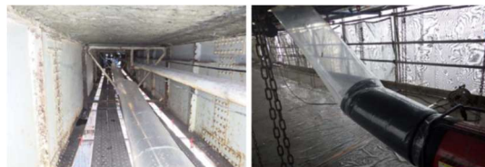
写真5 ジェットファーンレス養生状況
