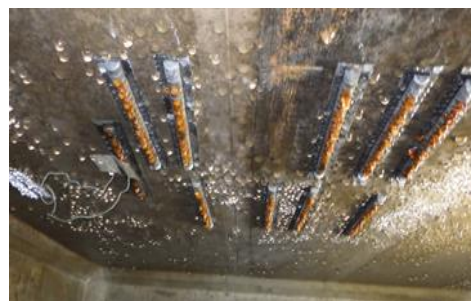
図 2. 天井部に貼り付けた鉄筋サンプルの様子
