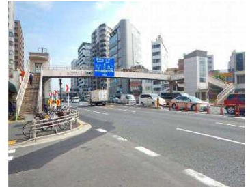
図-1 管理歩道橋の一例
