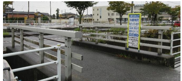
図2. 計測対象となった橋梁の1つ(橋梁⑤)
