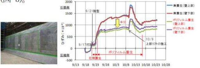
左:写真-2 ポリフィルム養生(壁面) 右:現場検証の壁表面部ひずみ履歴(国交省:矢切函渠その9工事)
