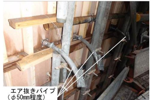
写真-5 打設時のエア抜きパイプ(立坑接続部)
