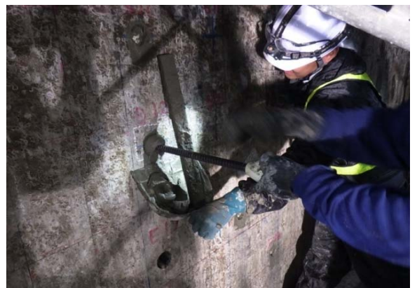
写真-2 可塑性グラウトを用いた挿入状況
