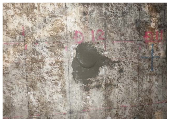
写真-3 CCb挿入および グラウト充填完了状況
