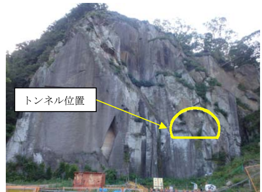
写真-1 法面状況(伐採後)
