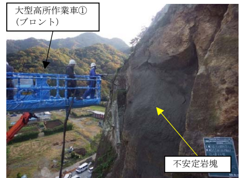
写真-4 岩塊崩落対策状況
