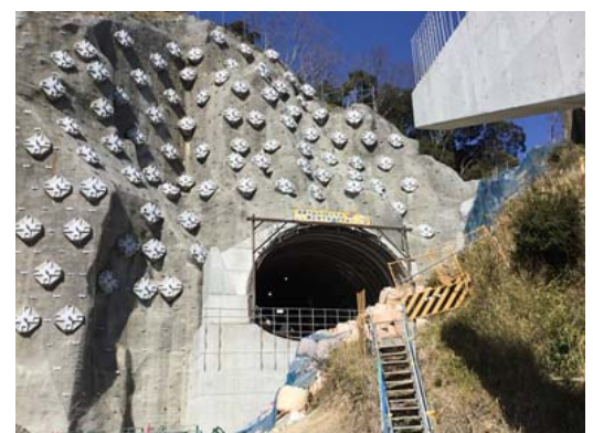
写真-7 法面全景(施工完了後)
