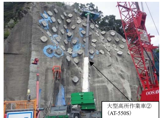
写真-5 大型高所作業車②
