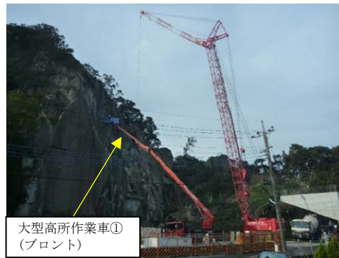
写真-3 大型高所作業車①
