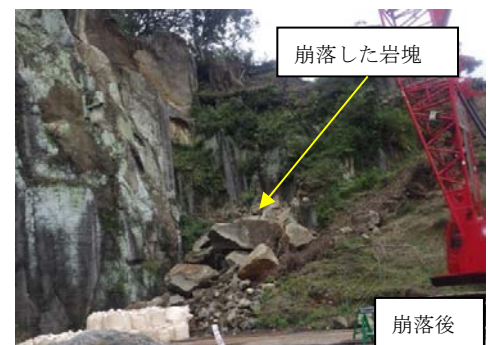
写真-2 岩塊崩落状況
