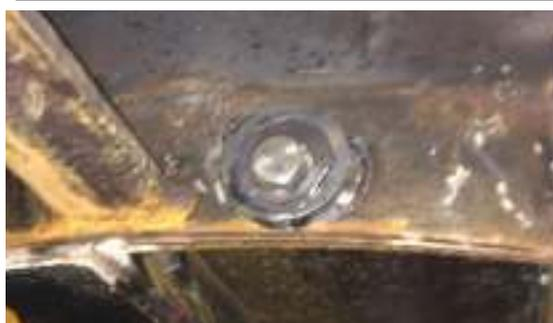
写真-1 真円度修正継手組立(天端)
