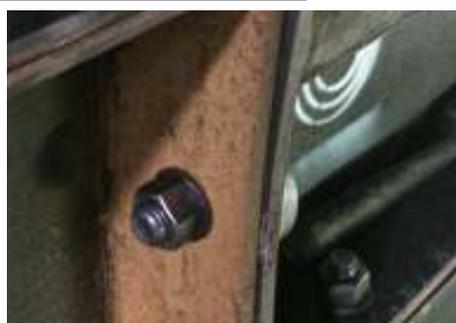
写真-2 真円度修正継手組立(サイド)
