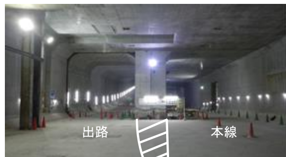
写真-1 施工完了写真
