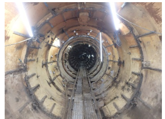
写真-1 シールド接合後の坑内の様子
