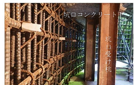
写真－2 坑口下部杭基礎
